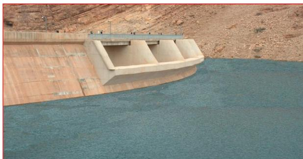
**Barrage Hassan II :** Il est situé dans la province de Taourirt sous forme d'un arc de béton. Son volume de retenue varie entre 109 et 270 millions m<sup>3</sup> avec un débit de 710 m<sup>3</sup>/seconde pendant la période pluvieuse et 450 m<sup>3</sup>/seconde durant l'été.
