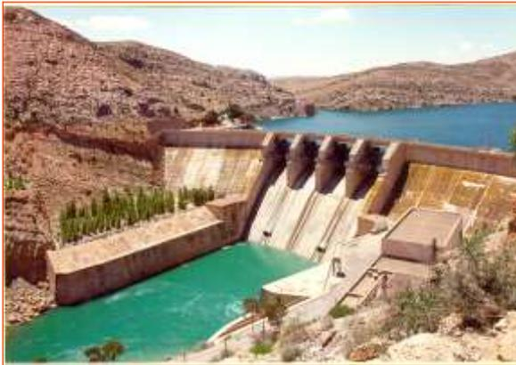
**Barrage Mohammed V :** Cet ouvrage mis en service en 1967 avec une hauteur de 64 m, est le plus grand réservoir d'eau de la région avec un volume de retenue de 411 millions m<sup>3</sup>. Il recueille les eaux d'un bassin d'une superficie de 50.000 km<sup>2</sup>
